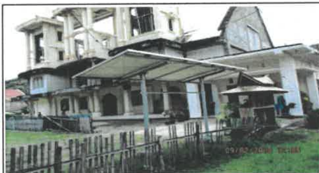
Pembangunan Pembangkit Listrik Tenaga Surya (PLTS)
