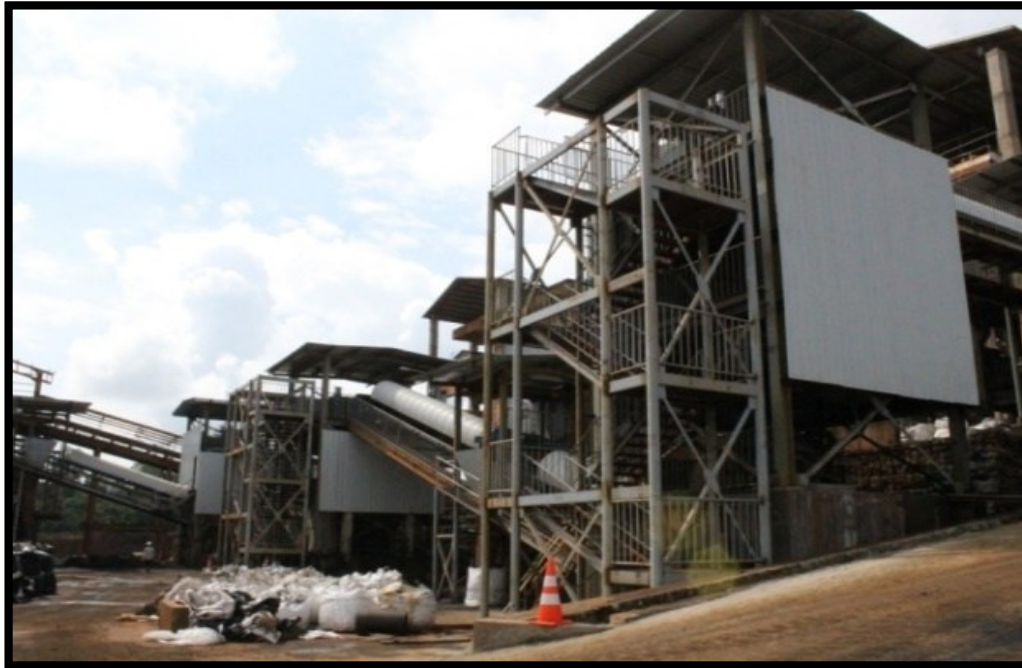
Gambar 3.21. Fasilitas Pengolahan dan Pemurnian PT Sebuku Iron Lateritic Ores (1)
