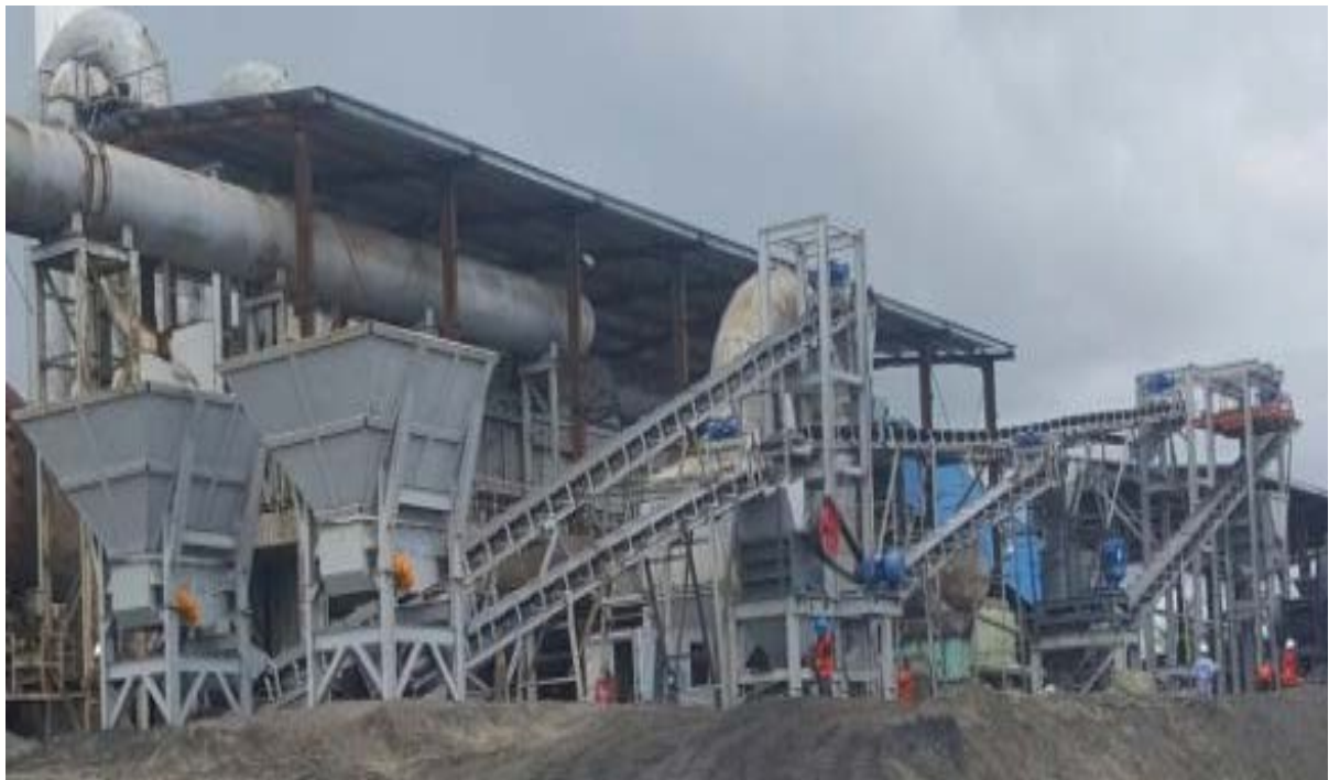
Gambar 3.13. Fasilitas Pengolahan dan Pemurnian PT Sumber Baja Prima (2)
