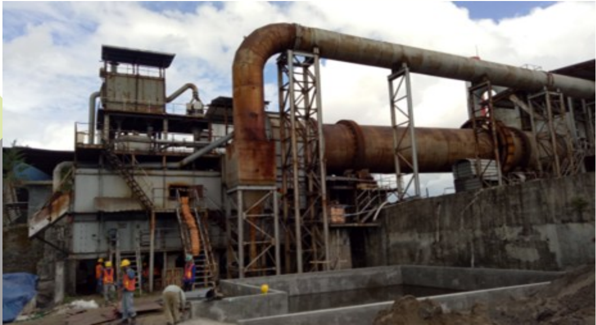
Gambar 3.12. Fasilitas Pengolahan dan Pemurnian PT Sumber Baja Prima (1)
